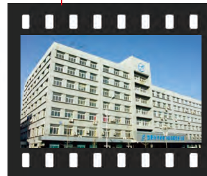
2009 年沈阳市铁西 老厂区正门和综合楼
