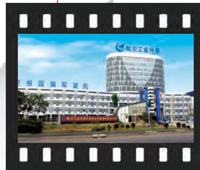
新厂区 701 科研办公大楼
